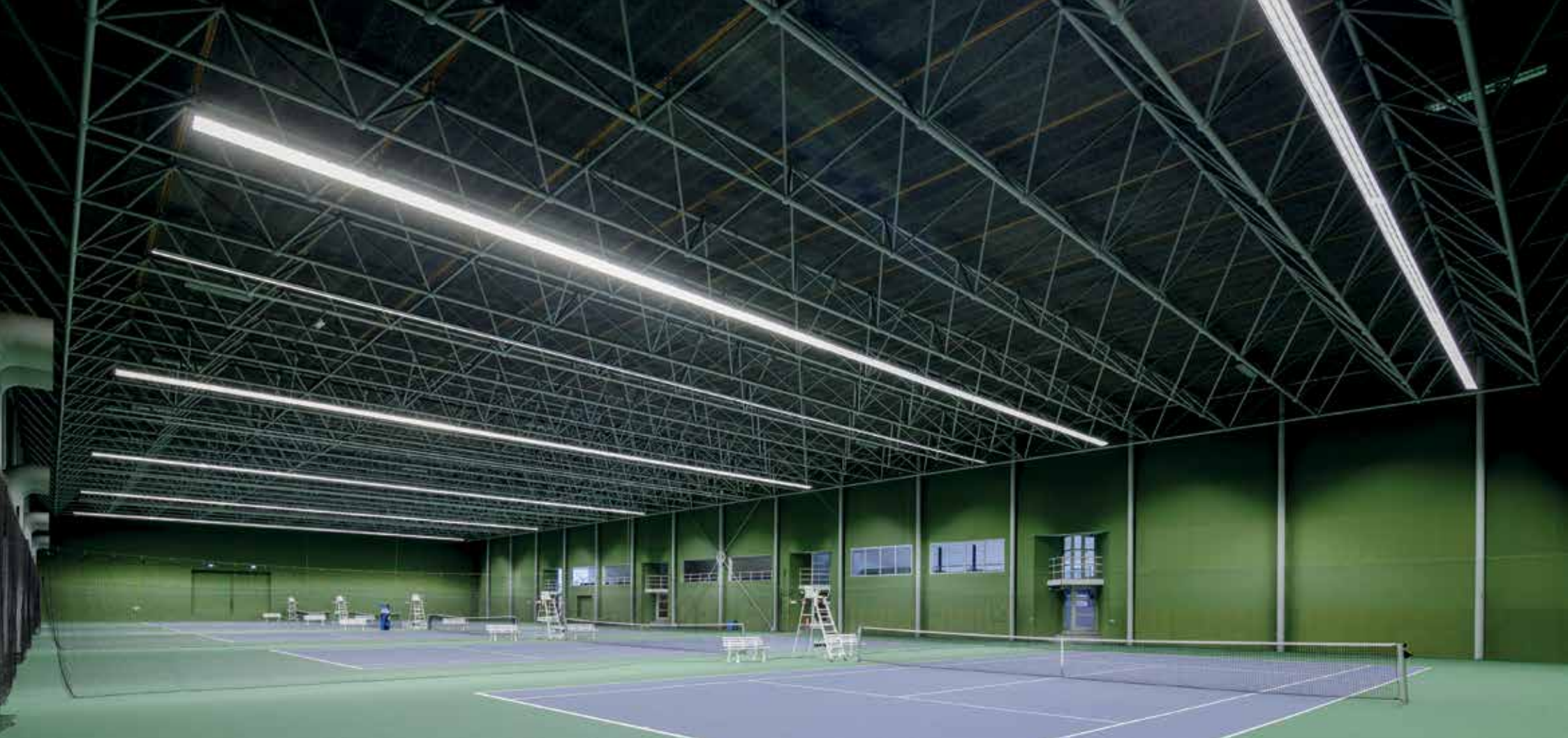
Hørsholm Rungsted Tennisklub, tennishal, Hørsholm / Bygherre: Codan Forsikring A/S / Arkitekt: Holm & Grut A/S Ingeniør: B. Højlund Rasmussen / Hovedentreprenør: C.G. Jensen A/S / Stålentreprenør: Scanspace A/S og Levi Jensen
