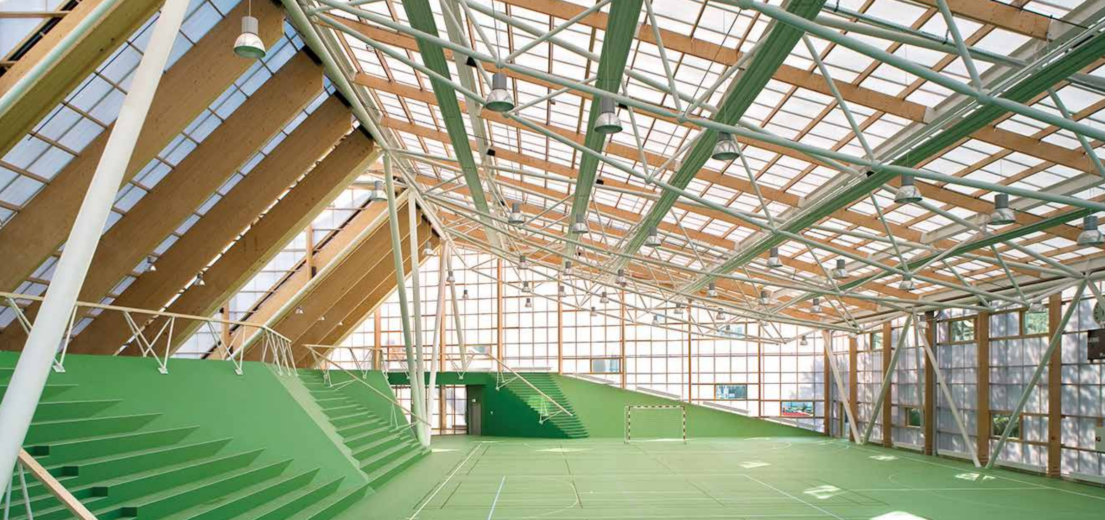
Prismen, idræts- og kulturhus, København / Bygherre: Københavns Kommune / Arkitekt: Dorte Mandrup Arkitekter A/S Ingeniør: Jørgen Nielsen Rådgivende Ingeniører A/S / Hovedentreprenør: N.H. Hansen & Søn A/S og Zacho-Lind A/S / Stålentreprenør: Levi Jensen
