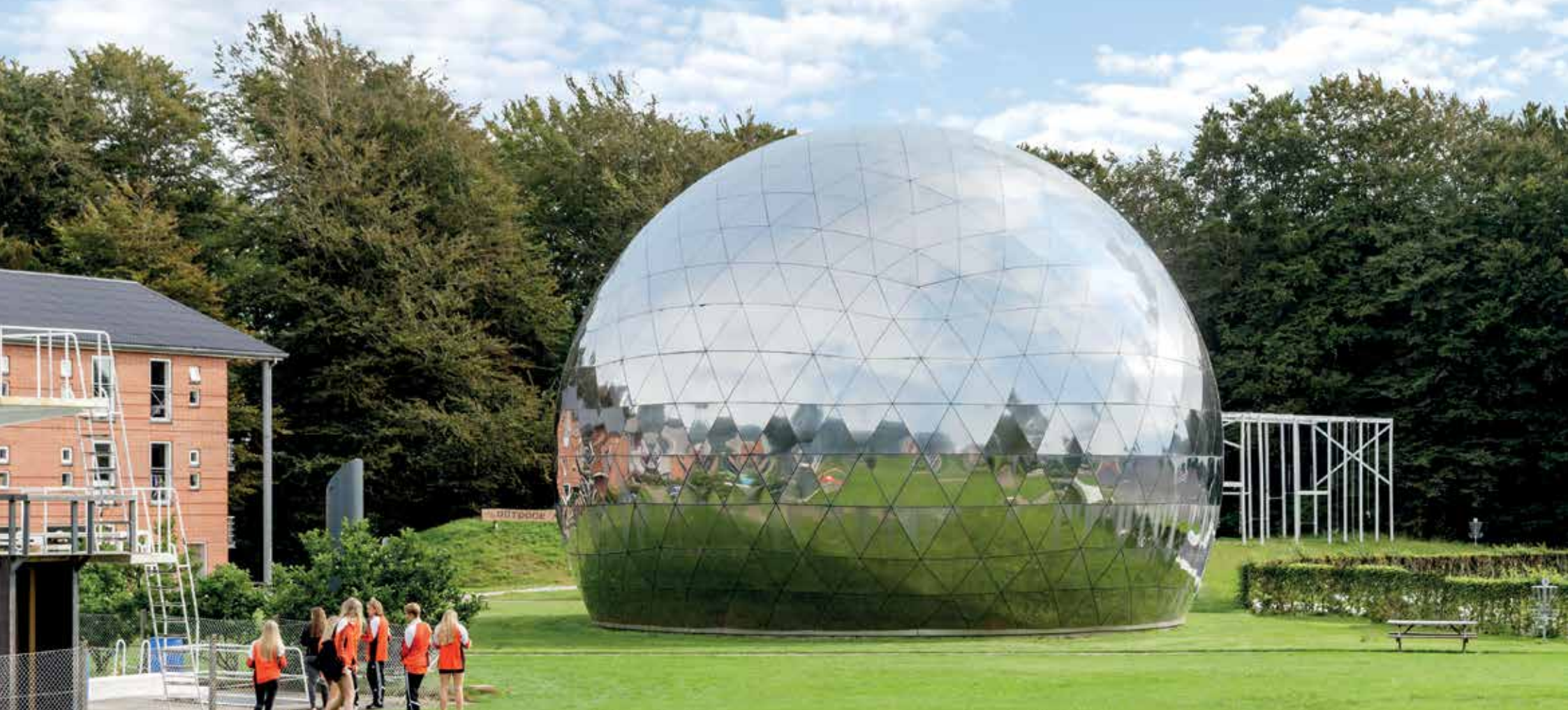
Vejle Idrætshøjskole, Vejle / Bygherre: Den Jyske Idrætsskole / Arkitekt: Felthaus Arkitekter A/S Ingeniør: Strunge & Hartvigsen Rådgivende Ingeniører Vejle A/S / Hovedentreprenør: Larsen & Nielsen A/S / Stålentreprenør: Scanspace A/S og Levi Jensen
